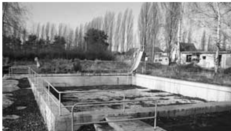
Das Becken des Barbyer Schwimmbads wird nun definitiv abgebrochen.
