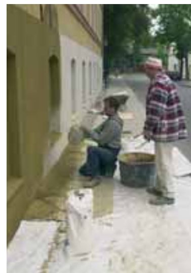
Die schäbige Fassade in der Schloßstraße ist Geschichte.
