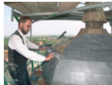
Dachdecker Werner Jännicke beim Schieferplattenannageln am barocken Türmchen.
