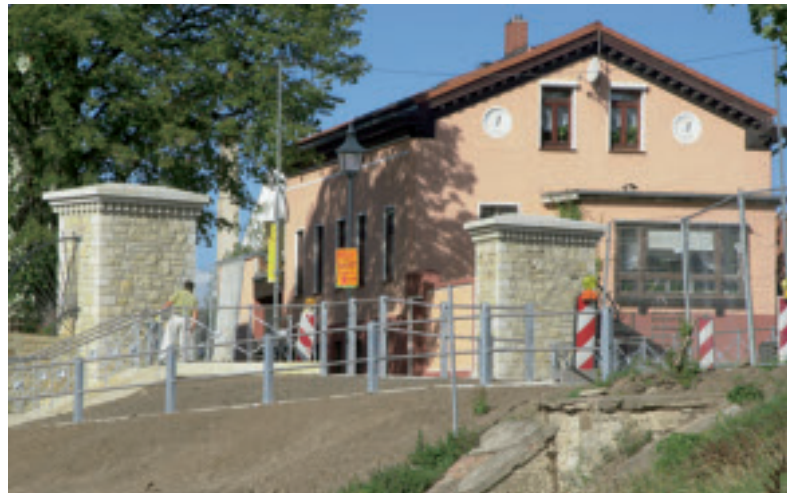
Die gelungene Sanierung des Barbyer Brücktors ist abgeschlossen.
