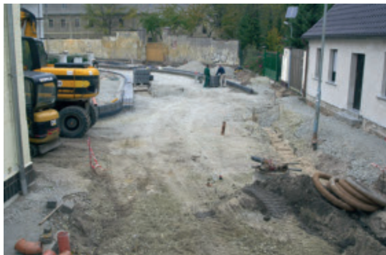
Bis zum Jahresende soll der erste Bauabschnitt der Schleiermacherstraße fertig sein.
