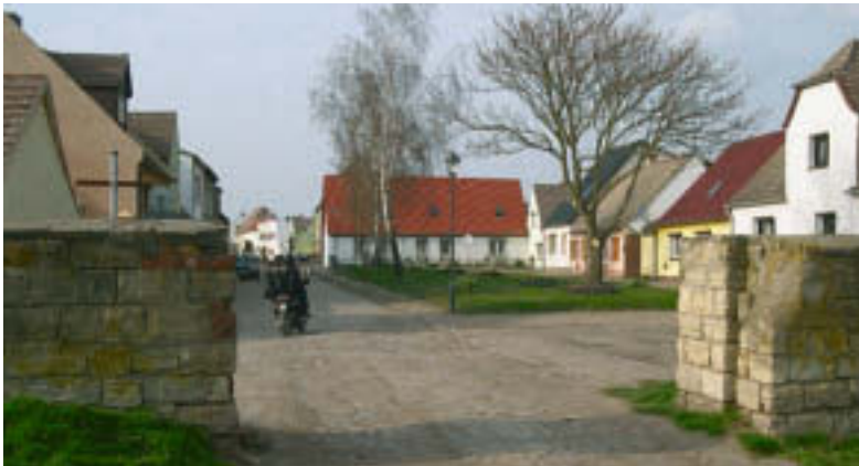
Wo bisher die Deichscharte mit Balken und Mist abgedichtet wurde, sollen jetzt verschleißbare Hochwassertore eingebaut werden.
