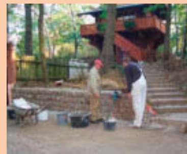
Zwei Maurer mit Herz arbeiteten an der Abschlussmauer, um das Umfeld der neuen Blockhütte zu vollenden.
