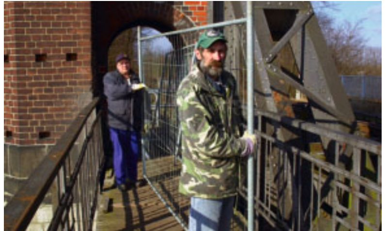
Mitarbeiter der Beschäftigungsgesellschaft Gesas sanieren den Brückenüberweg.
