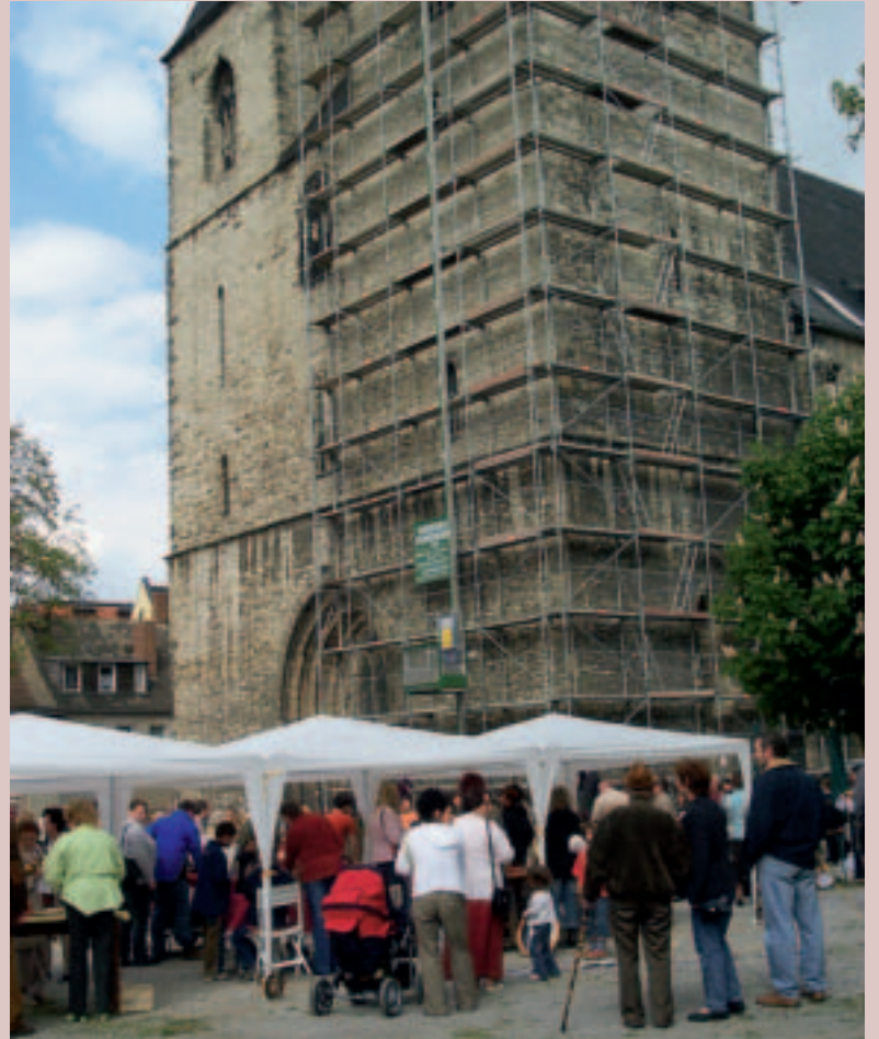
Unter dem eingerüsteten Südturm wurde das Kirchplatzfest gefeiert.
