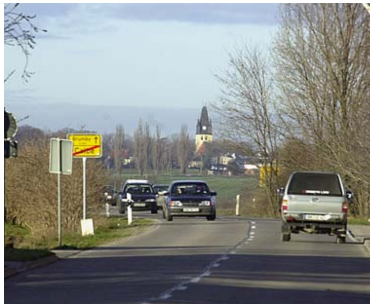
Die neue Ortsumgehung soll nahe der Shell-Tankstelle im Brumbyer Weg einmünden.
