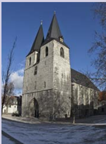
In diesem Jahr soll der Nordturm der Stephankirche saniert werden.
