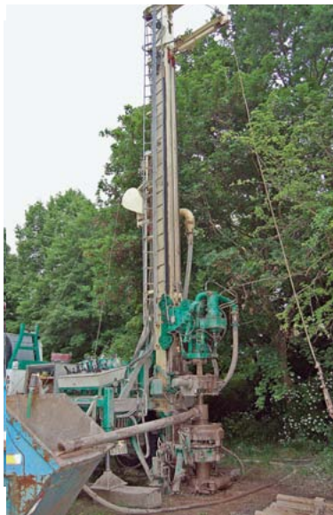
Die Bohrung hinter dem Haus gründet in etwa 100 Metern Tiefe, von wo dann die Erdwärme für die Heizung und die Kälte für die Klimaanlage genutzt wird.
