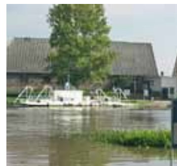
Beim letzten Herbsthochwasser ver-rutschte der Fähranker.
