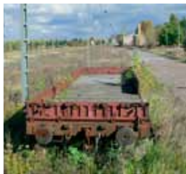
Der ehemalige Güterbahnhof Calbe (West) könnte wieder mit Leben erfüllt werden.
