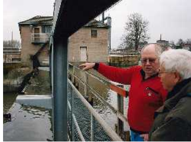
Dem Buchtenkraftwerk einen Besuch abgestattet.
