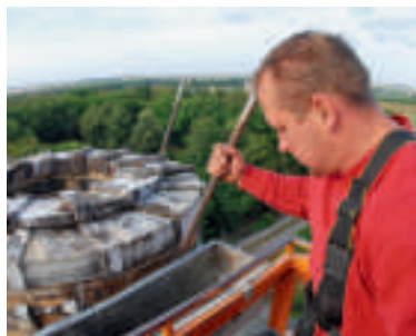
Stefan Schulze begutachtet vor der Montage in 30 Metern Höhe den Schornsteinkopf.
