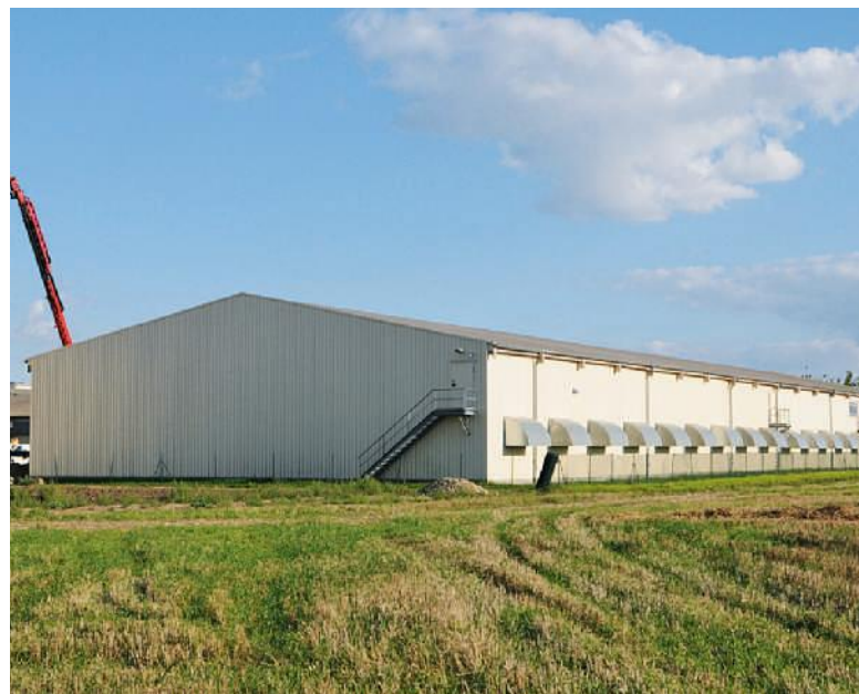
Am Brumbyer Weg wurde eine neue Lagerhalle für Zwiebeln errichtet.
