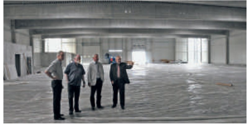
Die rund 3000 Quadratmeter große Produktions- und Logistikhalle soll im Oktober der Nutzung übergeben werden.
