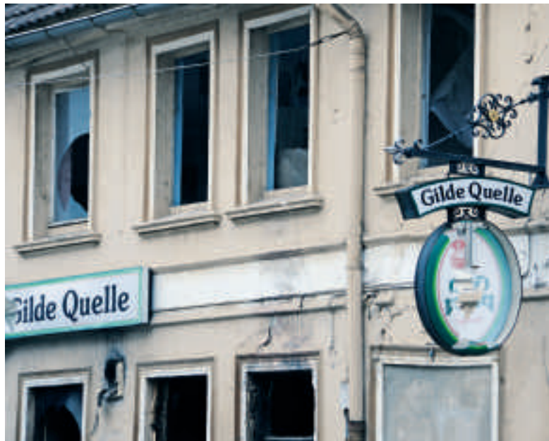
Die Gilde-Quelle wird abgerissen.
