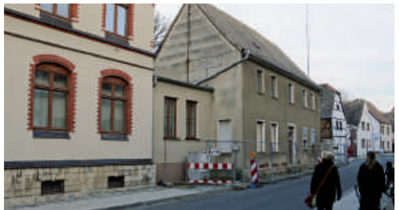
Das Haus neben der Post in Barbys Breite sollte schon 2005 abgerissen werden. Die Verengung der Straße deutet auf ein historisches Stadttor hin.
