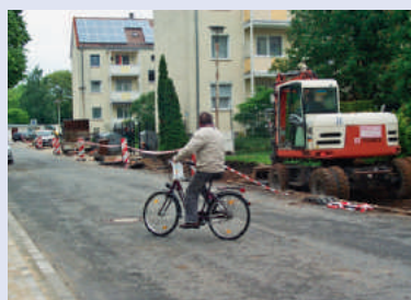
Der Ausbau der Friedrich-Ludwig-Jahn-Straße war seit Mai im vollen Gange.
