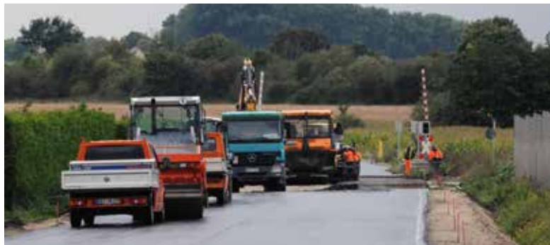
Erst Mitte September wurde der Asphalt aufgebracht.
