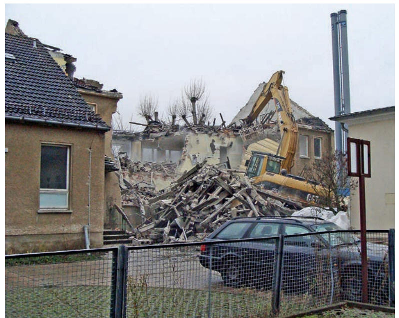
Bereits im Dezember wurde der Hort der Lessingschule abgerissen.
