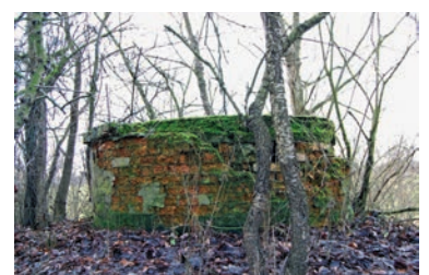
Alter Tiefbrunnen an der Elbe.
