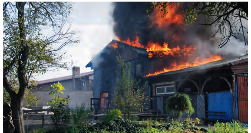
Das Stall- und Werkstattgebäude brannte vollkommen nieder.
