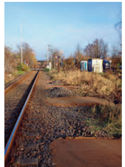
Hier entsteht der Haltepunkt Calbe-Stadt.
