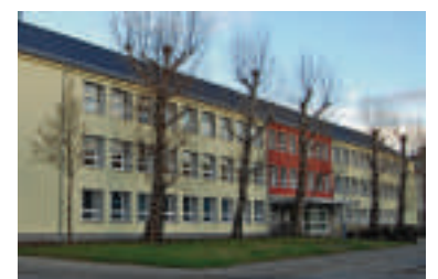
Die Grundschule im Januar 2015
