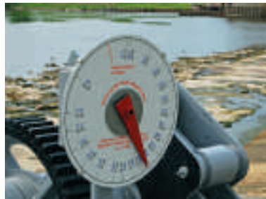
Die Anzeigetafel ist montiert
