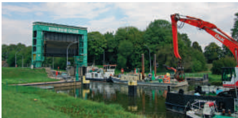
Arbeiten im Schleusenbereich 2015.
