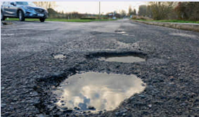
Die Zufahrt zum Gewerbegebiet soll 2016 saniert werden.
