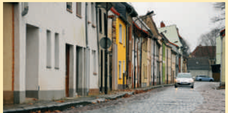
Die Straße „Neustadt“ soll grundhaft saniert werden.
