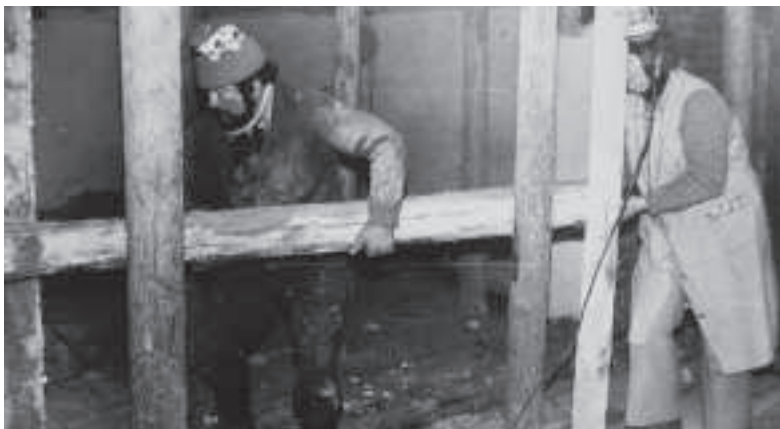
Bauzustand der Handwerkerstube 1981.
