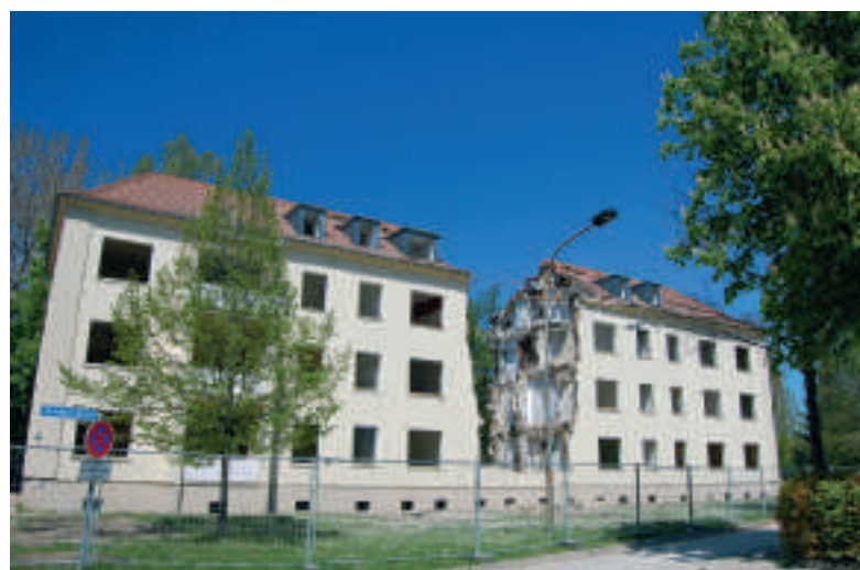
Abriss nach 58 Jahren.
