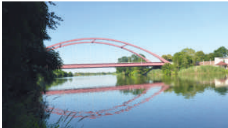
Die 1996 eingeweihte Saalebrücke soll 2018 saniert werden.
