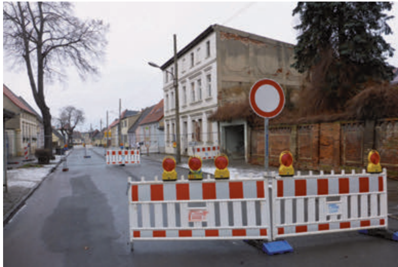
Wegen dieses Hauses musste die Nienburger Straße voll gesperrt werden.
