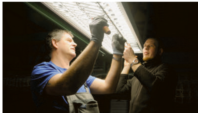
Steffen Fischer und Ronny Arlandt (r.) beim Installieren der Leuchten. Foto Thomas Linßner
