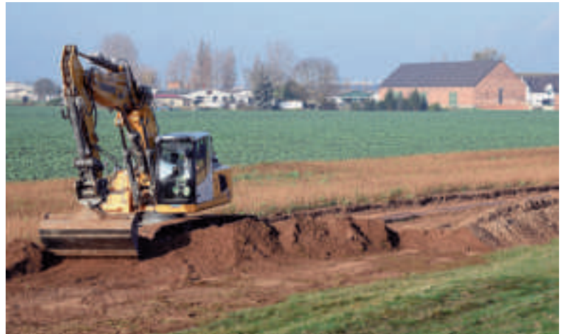
Der Deich zwischen Barby und Glinde wird DIN-gerecht ertüchtigt.
