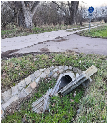
Müllablagerung an der Zufahrt zum Radweg Damaschkeplan - Calbe
